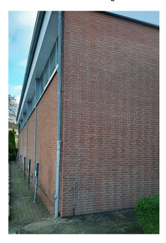
Lange Zeit gab es eine Baustelle an der Turnhalle im Almtweg. Im Bereich der Regenfallrohre gab es gravierende Beschädigungen an der Fassade. Viele Monate sah man die schadhaften Stellen im "Mauerwerk". Beim genauen hinsehen erkennt man aber, dass es sich nicht um ein Vollmauerwerk handelt, sondern um eine Riemchenverkleidung.
